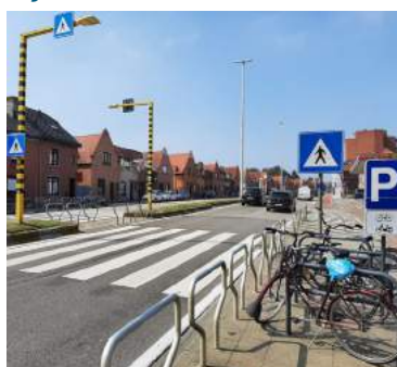
Gefaseerde oversteek met verlengde zebrapaden Tervuursevest, Leuven
